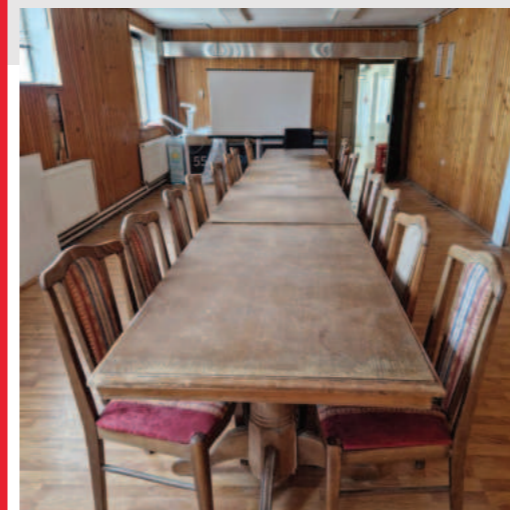
SEPARE PRE REKONSTRUKCIJE
